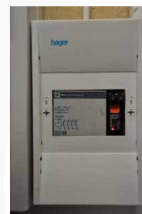
Kontaktorn med manöverrelä inbyggd i extern kapsling
